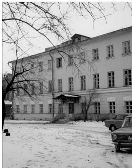
Боковой флигель Мариинской больницы. Слева от крыльца на первом этаже – окна Достоевских. 1984 год.
